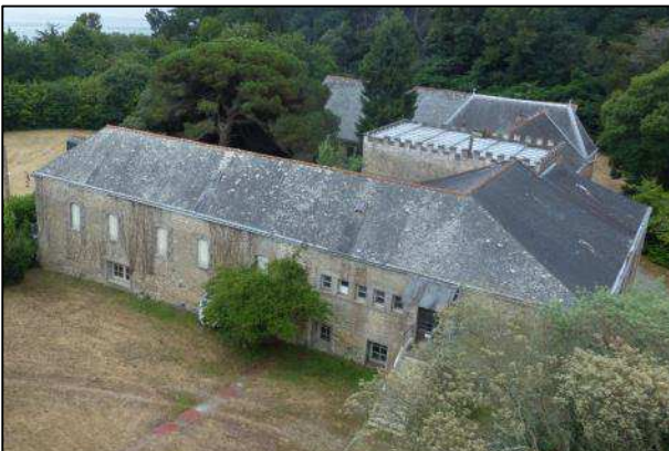
Vue générale de la grange
