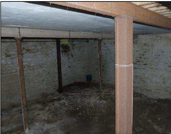
Sous-sol du bâtiment
