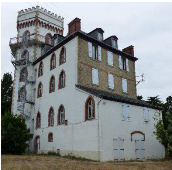
Vue générale de la Tour
