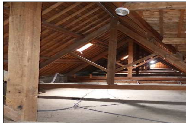
Les combles de la grange
