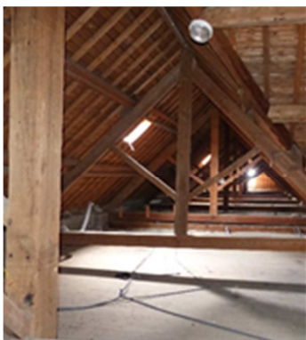
Les combles de la grange
