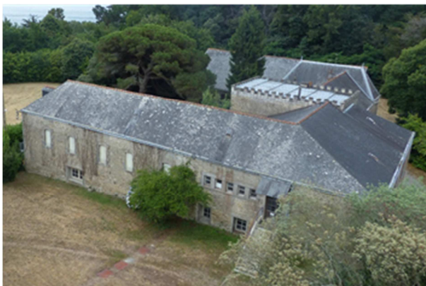
Vue générale de la grange
